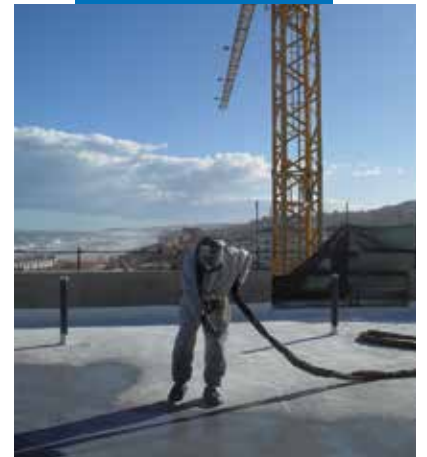
Triblock P üzerine Purtop 400 M uygulanması
