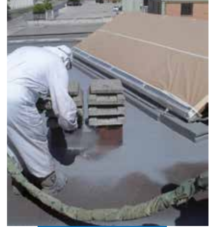
Bitümlü membran üzerine Purtop 400 M uygulanması
