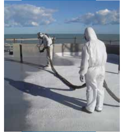
Triblock P üzerine Purtop 400 M uygulanması
