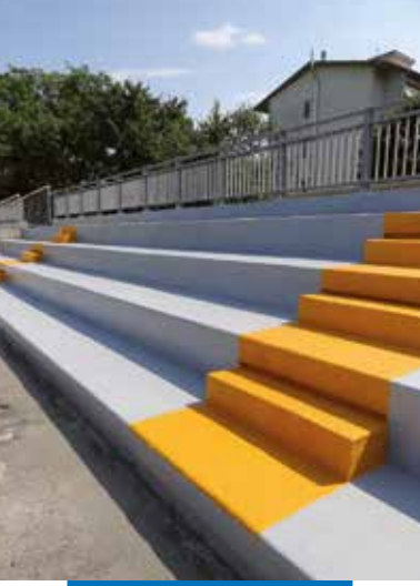
Mapecter Finish 55 ile kaplanmış, Purtop 400 M ile su yalıtımı sağlanmış basamaklar
